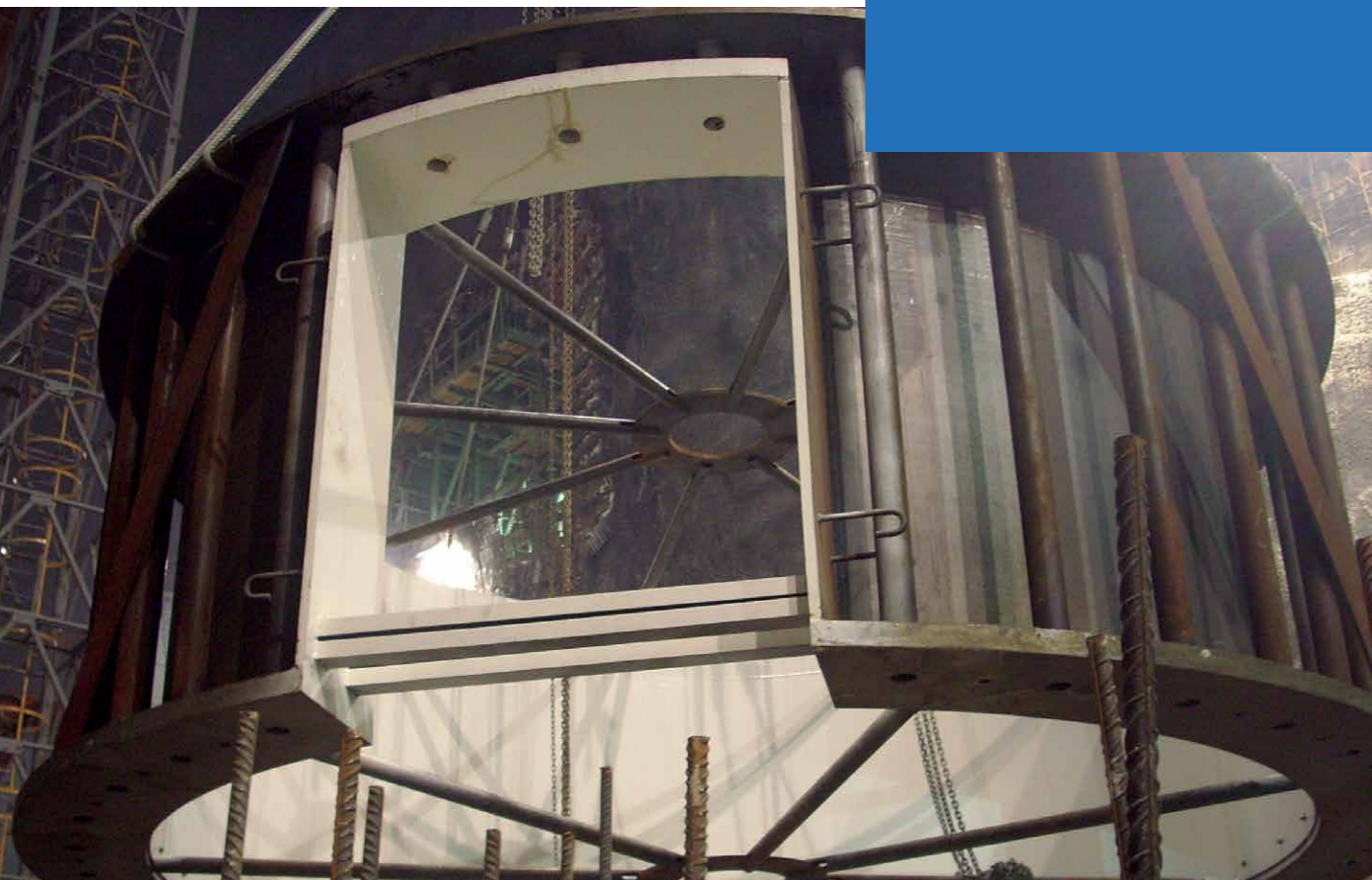
Info: Montaje en zona distribuidor Info: Assembling in distributor zone
